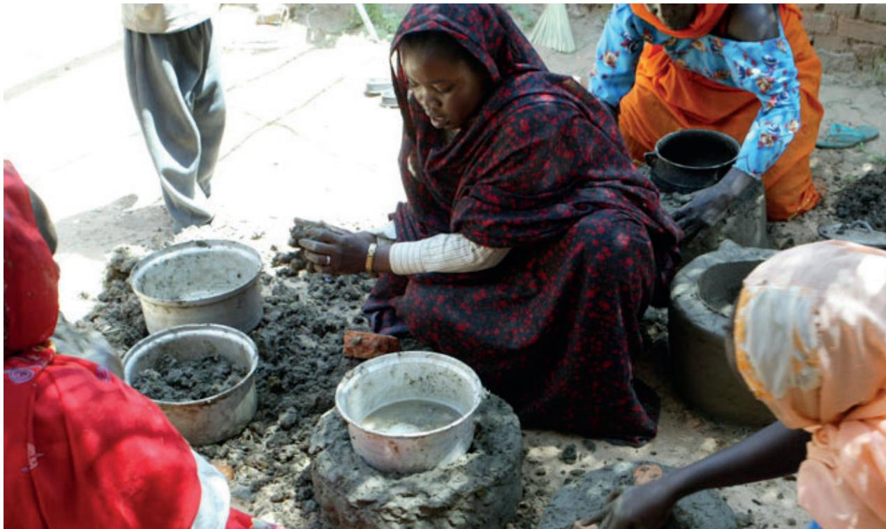
*Des fourneaux de base améliorés peuvent être fabriqués avec des matériaux disponibles localement, et ce presque gratuitement : des femmes déplacées dans le Darfour occidental, au Soudan, apprennent à fabriquer des fourneaux à faible consommation de combustibles à partir de boue.*
